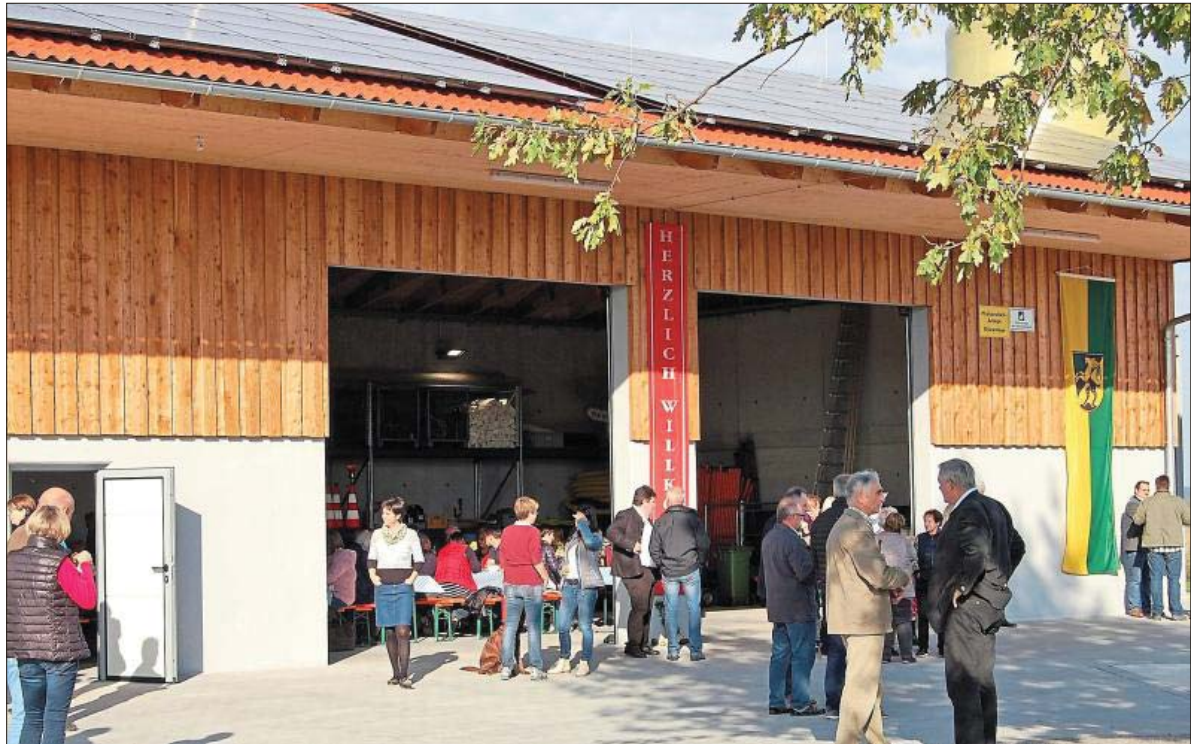
Die Bürger konnten die neue Bauhofhalle besichtigen.
